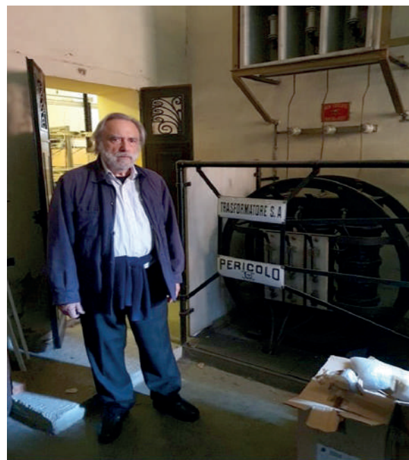
Locale contenente la cabina elettrica di alimentazione 3.000/220-125 Volt dell'Istituto Aldini Valeriani negli anni '30, dotata di due trasformatori MT/BT (3.000/220-125V) aventi ciascuno una potenza di 110 KVA
