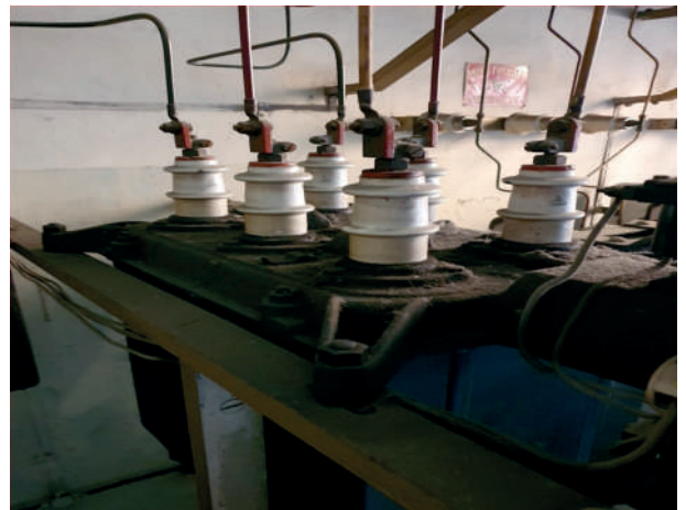
Particolare di riduttore di corrente (TA), isolato on olio, utilizzato per gli strumenti amperometrici
