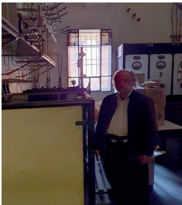
Locale contenente la cabina elettrica di alimentazione 3.000/220-125 Volt dell'Istituto Aldini Valeriani negli anni '30, dotata di due trasformatori MT/BT (3.000/220-125V) aventi ciascuno una potenza di 110 KVA
